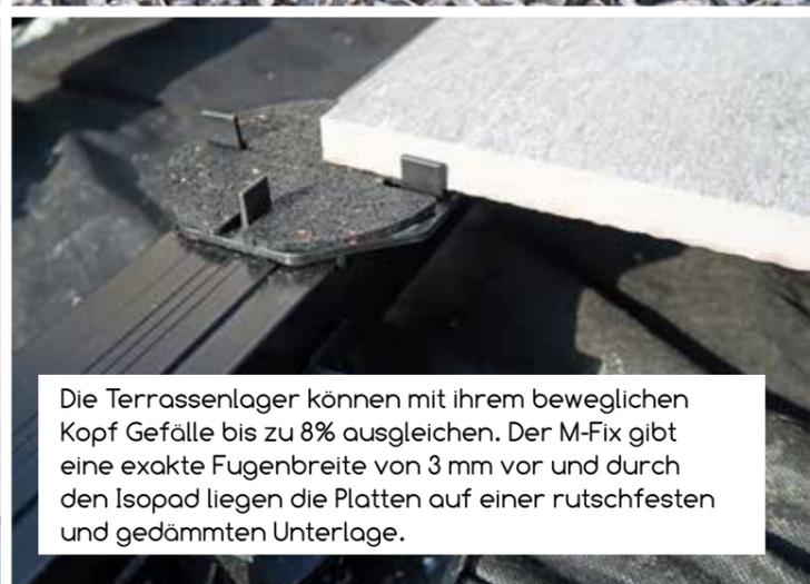
Die Terrassenlager können mit ihrem beweglichen Kopf Gefälle bis zu 8% ausgleichen. Der M-Fix gibt eine exakte Fugenbreite von 3 mm vor und durch den Isopad liegen die Platten auf einer rutschfesten und gedämmten Unterlage.
