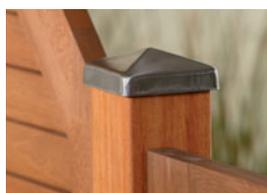
**Konstruktiver Holzschutz:** Schützen Sie die schichtverleimten Hartholzpfeiler zwingend mit Kappen aus Edelstahl, Seite 21.
