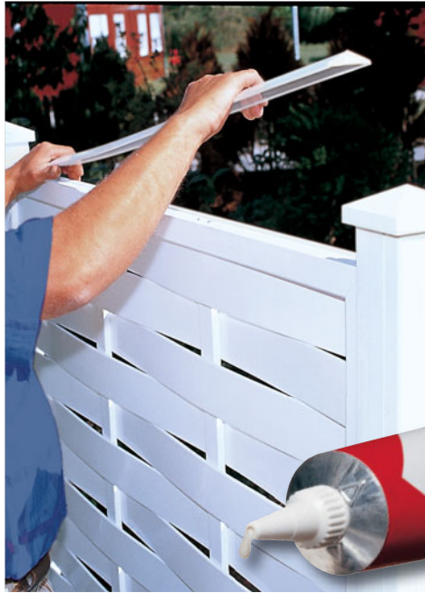
Kleber (0783) zur Befestigung der Aufsatzleisten und Kappen.
