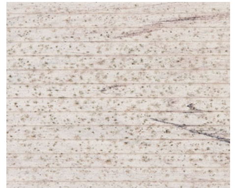
Stockflecken/Schimmel auf der Oberfläche
