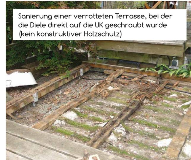
Sanierung einer verrotteten Terrasse, bei der die Diele direkt auf die UK geschraubt wurde (kein konstruktiver Holzschutz)
